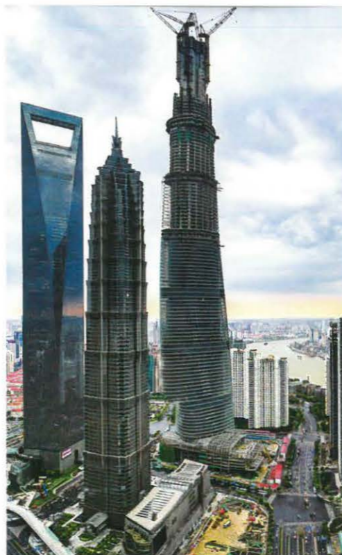
Der Shanghai Tower: Rexroth-Pumpen gossen das Fundament.
