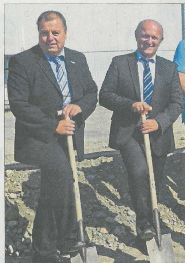
Spatenstich für weiteres Wachstum bei ViscoTec: die Geschäftsführer Martin Stadler und Georg Senftl. – F.: ede
